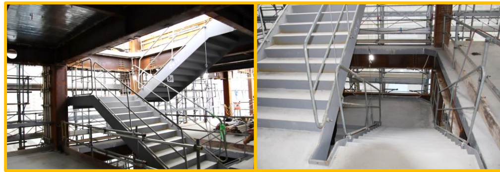
屋内中央階段工事中
