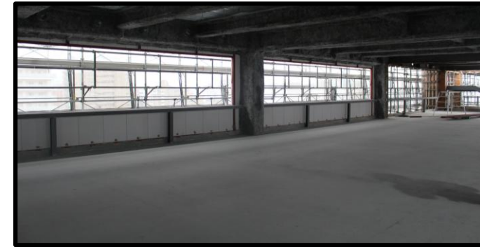
8階HR教室 施工中
